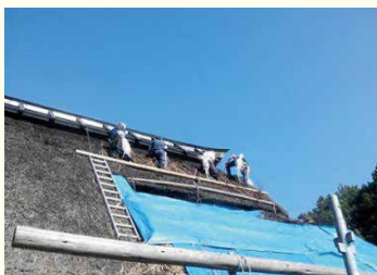
茅葺き屋根の葺き替え
